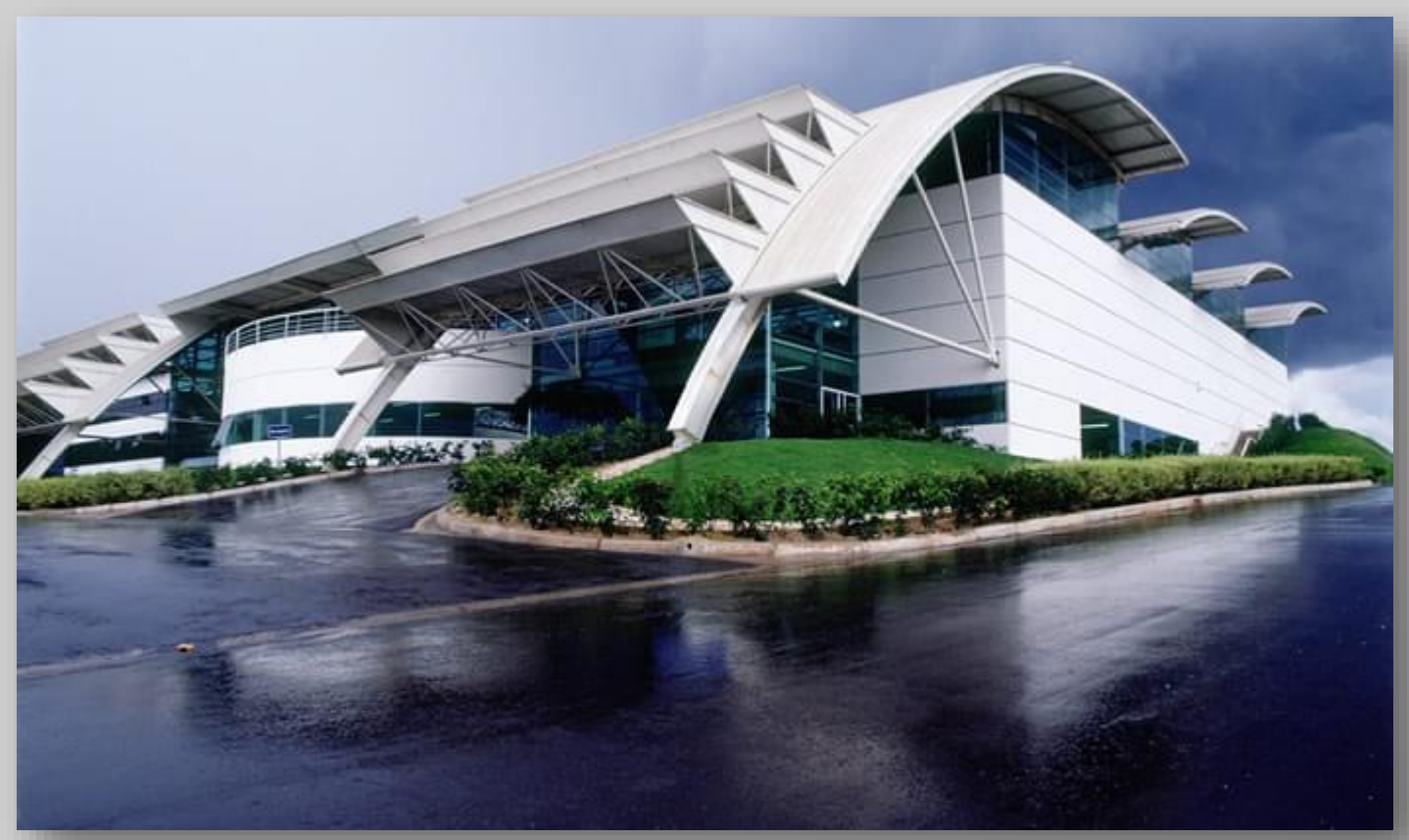
Ipêl fabrica de papel – Sidonio Porto Estrutura Metálica
