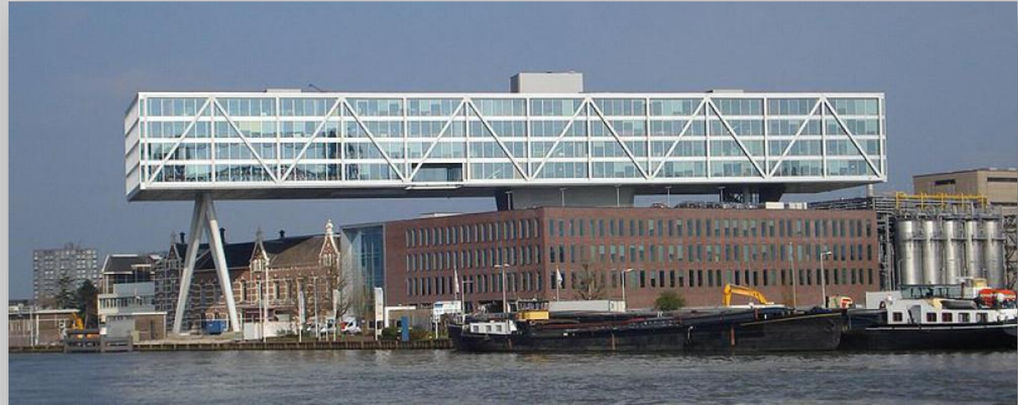
Escritório – Rotterdam estrutura metálica e fechamentos em sua maioria feitos por amplos painéis de vidro.
